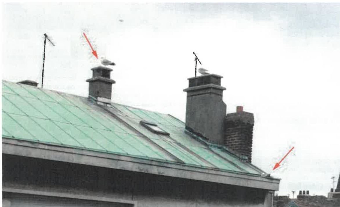
Photo 5.- La pose de pics sur les cheminée et dans les chéneaux empêche la construction des nids © Alain Ward
