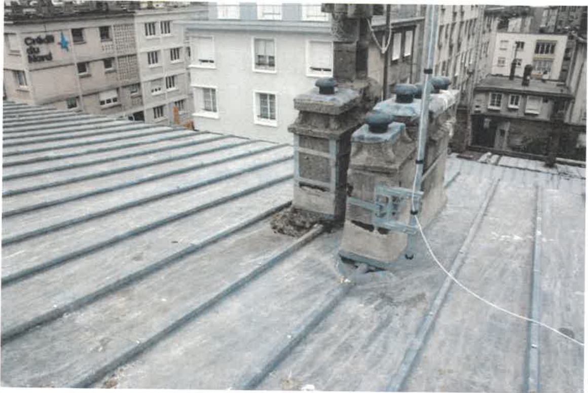
Photo 5.- Toiture en pente douce occupée qui nécessite la pose de pics sur les points d'accroche des nids © Alain Ward.
